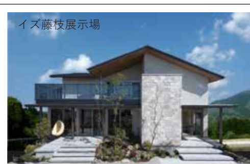
会場 藤枝市高洲1-5-29 藤枝住宅公園内
